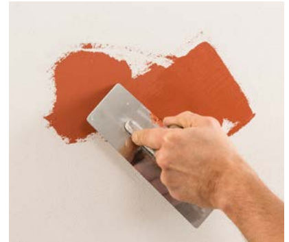
Fresco Veneziano gefleckt mit der Glättkelle aufspachteln.
