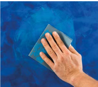
3. Lage Stucco Veneziano, anschließend schleifen (P1200).
