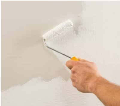
Grundieren mit Iso-Mineralgrund 309.
