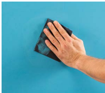
Fläche schleifen mit 320 er Schleifpapier.
