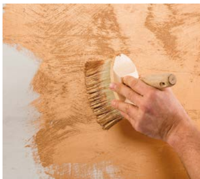
Jaeger Sabbia richtungslos auftragen.
