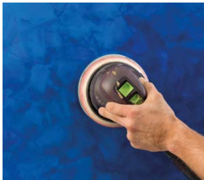
Polieren mit Festool Getriebe-Exzenter schleifer Rotex RO 150 FEQ. Alternativ kann manuell mit der Spachtel poliert werden.
