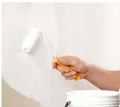
Grundieren der Fläche mit Jaeger Iso-Mineralgrund 309.
