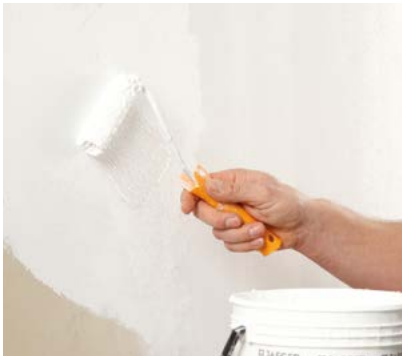
Grundieren der Fläche mit Iso-Mineralgrund 309.
