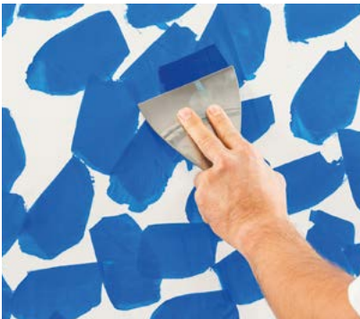
1. Lage Stucco Veneziano in Fleckspachtelung auftragen.
