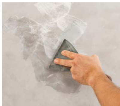
Kronen® Exquisit Finish dünnsschichtig in 1-2 Lagen aufspachteln.
