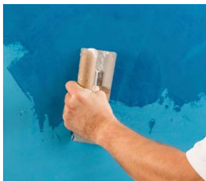
2. Lage Stucco Romano auftragen.
