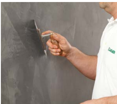
Fläche mit der Traufel verpressen.
