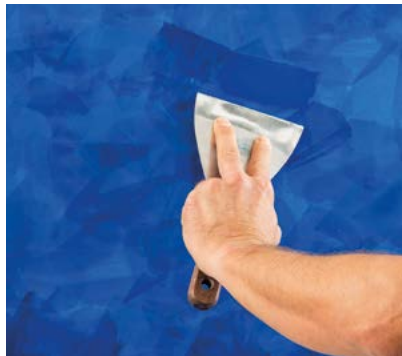
2. Lage Stucco Veneziano: Flecken schließen. Zwischenschliff mit P600.
