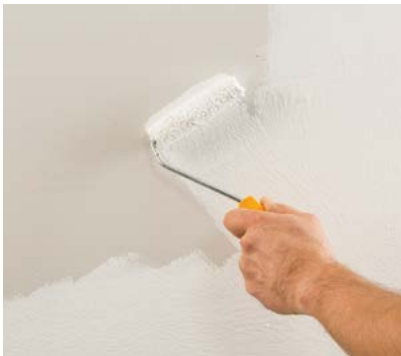
Grundieren mit Iso-Mineralgrund 309.
