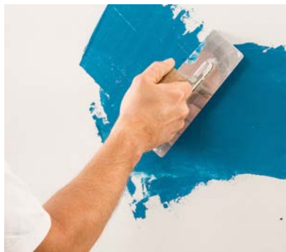
Nach dem Grundieren der Fläche mit Iso-Mineralgrund 309 wird die 1. Lage Stucco Romano mit der Traufel aufgetragen.
